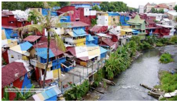
Gambar 5.5. Pembangunan di Sempadan Sungai (Sumber : Speak Indonesia, 2021)
