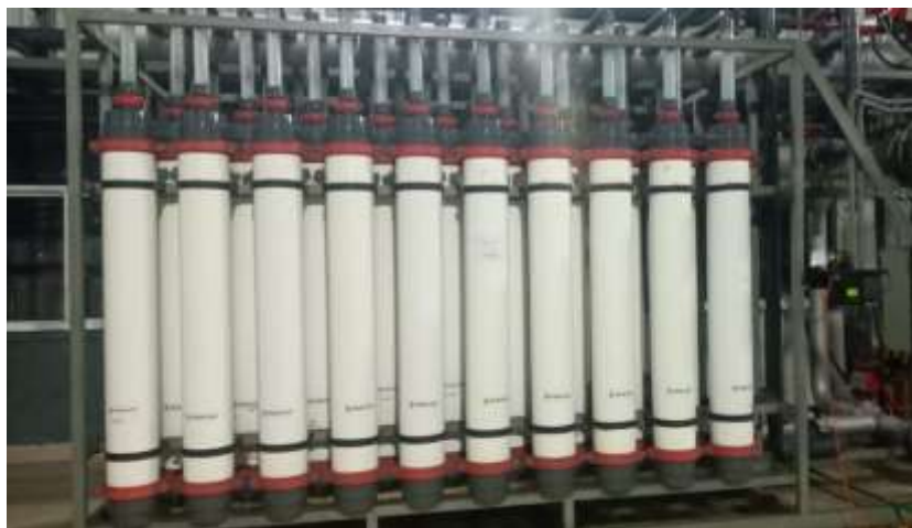
Gambar 7.3. Ultrafiltrasi pada unit pengolahan air (Sumber : dokumentasi pribadi)
