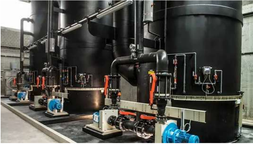
Gambar 7.5. Tangki penyimpanan bahan kimia untuk netralisasi (sumber: (Bahari, 2022))
