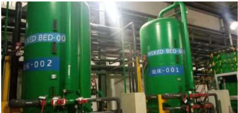
Gambar 7.6. Penukar ion pada unit pengolahan air (Sumber : dokumentasi pribadi)
