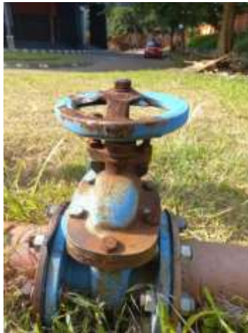
Gambar 8.1 : Logam Korosi (Sumber: Penulis)
