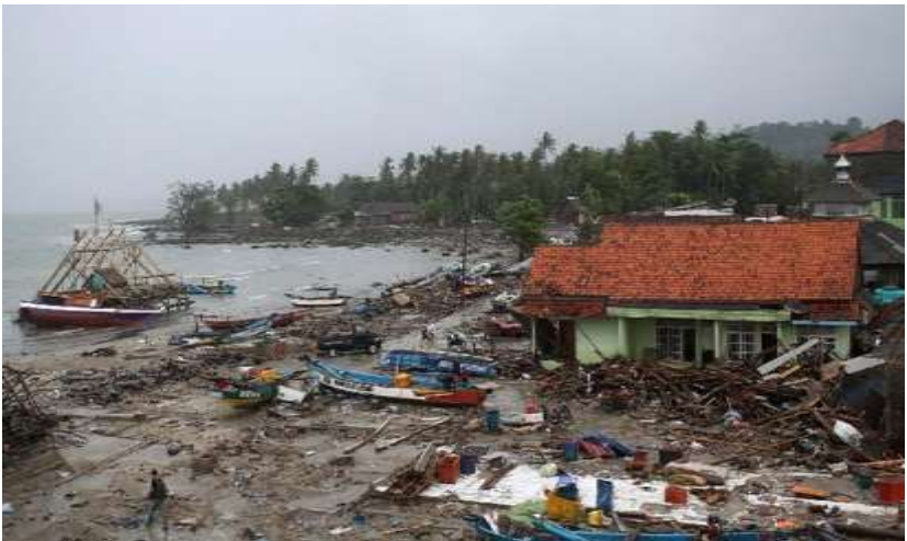
Gambar 8.3. Kerusakan dan kehancuran infrastruktur akibat tsunami (Parura and Rahardyan, 2020)
