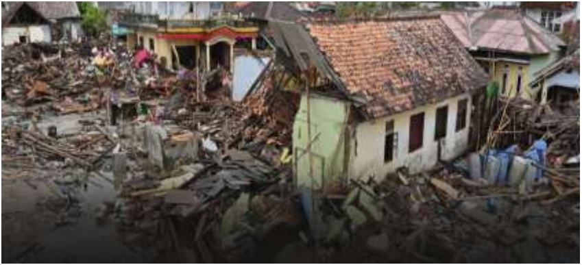
Gambar 8.2. Kerusakan dan kehancuran infrastruktur akibat tsunami (Fahmi et al., 2022)
