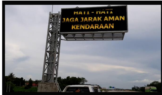
Gambar 7. 2. VMS di Jalan Tol Cipali
