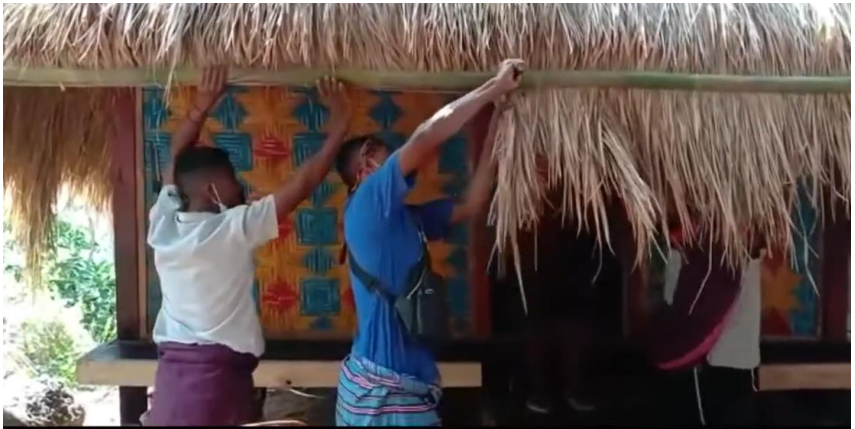
Gambar 10.4. Pemotongan bahan atap dalam proses restorasi bangunan tradisional (Sumber: (Pos Kupang, 2022))
