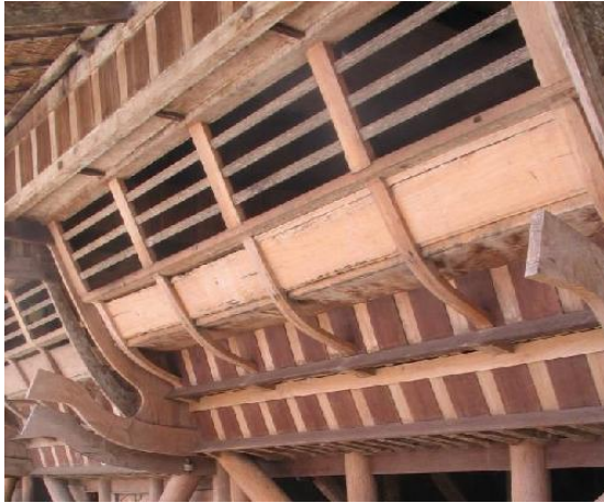
Gambar 5.19. Untuk memaksimalkan pencahayaan alami dan untuk penghawaan alami dibuat bukaan pada rumah Nias Sumber: (Manurung, 2014).
