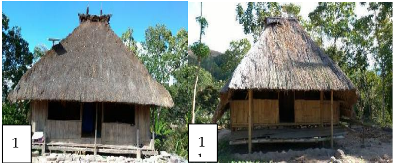
Gambar 5.1. a. wolo sozo atau struktur atap; 1b. penutup atap dari ki atau alang-alang
