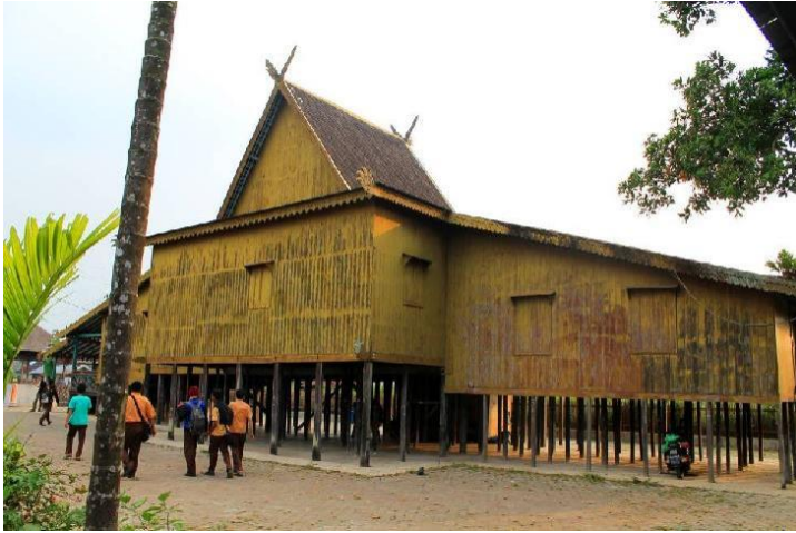
Gambar 5.21. Rumah Banjar menggunakan system arsitektur kolong atau rumah panggung Sumber: (Manurung, 2014).
