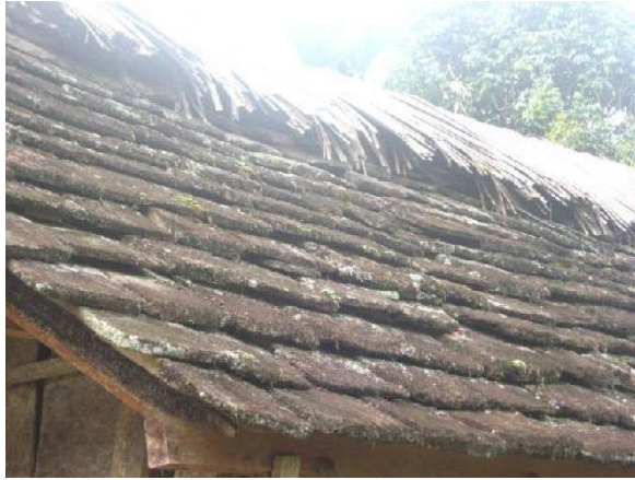
Gambar 5.10. Material atap yang digunakan yakni batu pada rumah Tongkonan di Toraja, Sulawesi Selatan Sumber: (Manurung, 2014).
