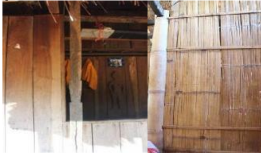
Gambar 5.4. Dinding di bangunan Sumber : Jasno, Fontaino and dan Yohanes W. D Kapilawi, 2019
