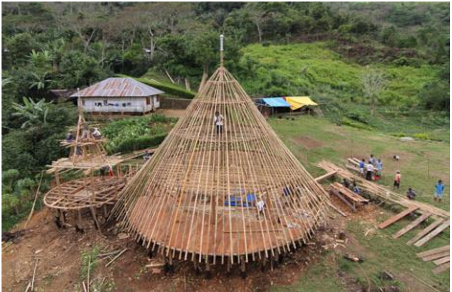
Gambar 10.2. Proses restorasi Mbaru Ning (Sumber : (Frearson, 2013))
