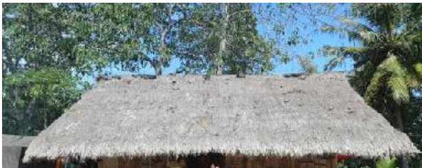
Gambar 5.7. Ki atau alang-alang sebagai material penutup atap
