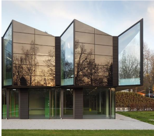
Gambar 9.3. Gedung Nursery +E di Jerman menggunakan panel surya custom di fasadnya (Sumber : architizer.com)
