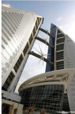
Gambar 9.4. Gedung Bahrain World Trade Center terintegrasi dengan turbin angin untuk memproduksi energi listrik (Sumber : skyscrapercenter.com)
