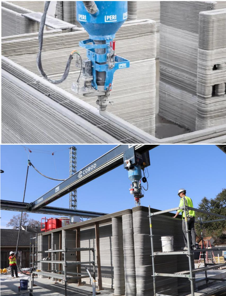
Gambar 5.12. Teknologi 3D Printing dalam Konstruksi (Sumber: Perkasa, 2023).
