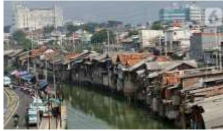
Gambar 2. Kondisi Permukiman Kumuh (Sumber: liputan6.com)
